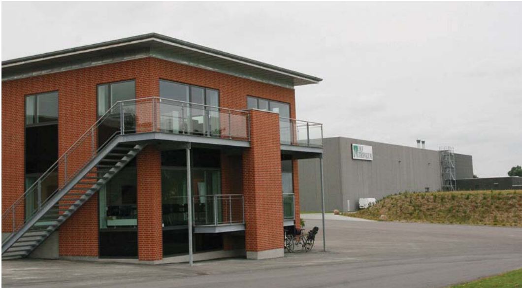
Lagerbygningen i baggrunden er et nyt højlager med plads til 7.800 store kasser med frø, der er stablet på mobilreoler, samt anlæg til at blande og opsække frø. DLF-Trifolium har investeret 61 mio. kr. i det nye højlager og den tilhørende kontorbygning i forgrunden.
